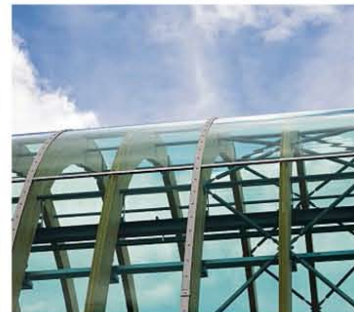
Was aus der Frontansicht wie eine geschlossene Tonne wirkt, ist in Wirklichkeit ein feines Gefüge aus Holzrippen und einer Glashaut.
