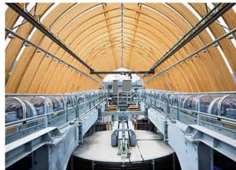
Bequemer Aufstieg mit erheblicher Kraftanstrengung. Die gesamte Technik über den Köpfen der Fahrgäste liegt in der gläsernen Tonne offen da.
