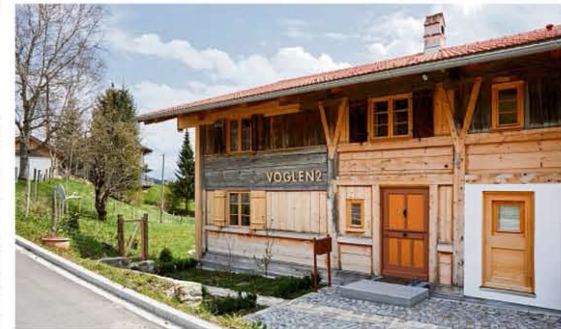
Der ursprüngliche Anblick: Ständer mit Kopfbändern markieren Wohn-, Flur-, Stallbereich; eingetutet 6 cm starke Bohlen, liegend im Brüstungsbereich, stehend zwischen den Fenstern.
