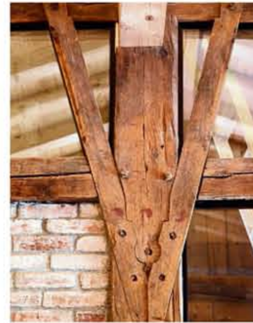
Überblattete Kopfbänder mit Holznägeln – konstruktiv zwingend und doch künstlerisch frei gearbeitet.
