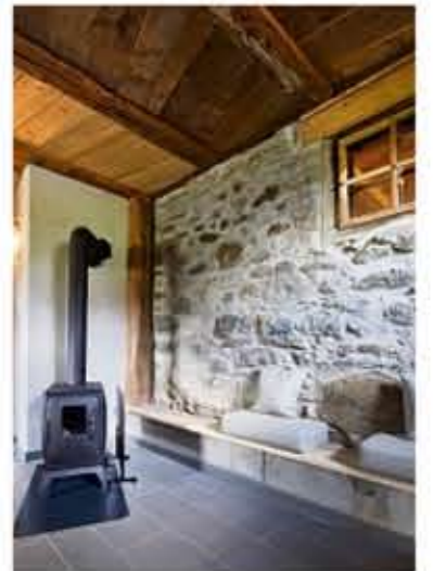
Zeuge der Verschiebung: Die alte Sockel-Außenwand ist nun Innenwand im neuen Wellness-Bereich im Souterrain.
