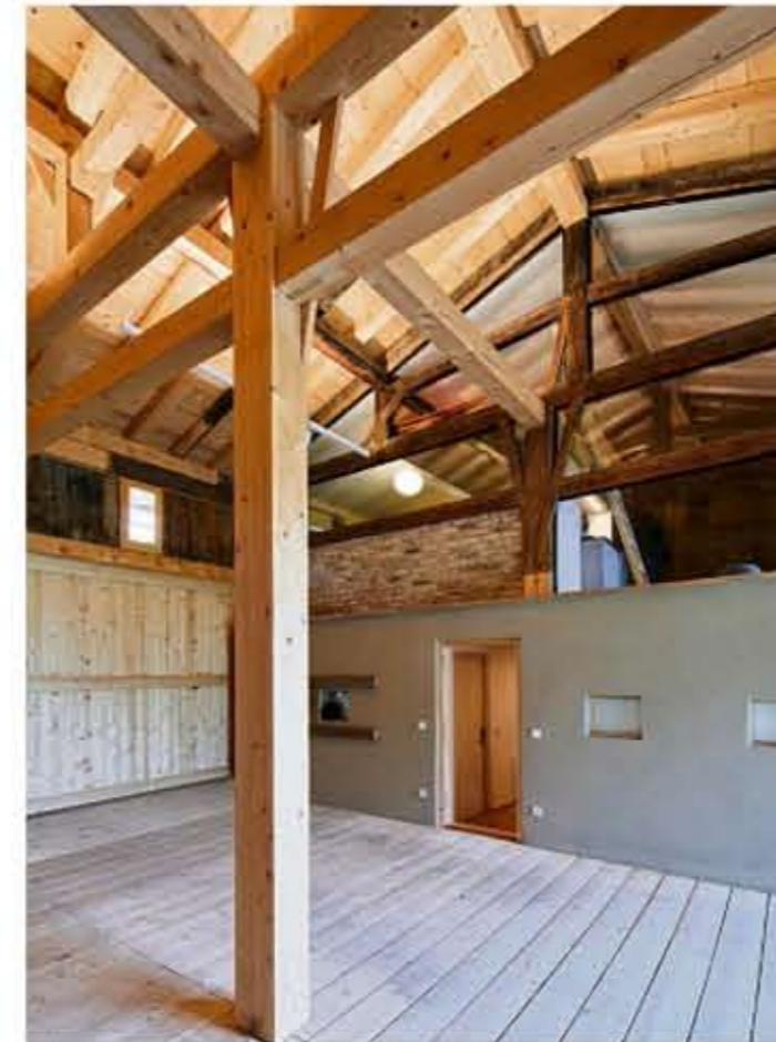
Vom Boden bis zum First: Das konstruktive Gefüge im Stadel mit versetzter Firststütze.
