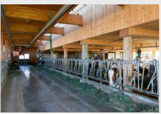
Bis auf wenige statisch geforderte Betonstützen ist Stall und Bergehalle aus Massivholz. Außenwände Pfosten-/Riegel-Konstruktion, Vollholz-Stützen 24/24 Zentimeter, 20 Zentimeter Brettstapel-Decke.
