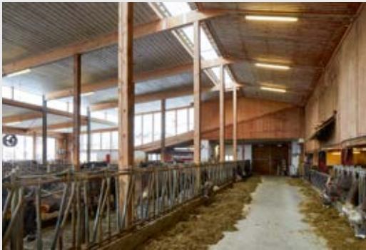
Über dem Futtergang neben dem Heulager erhielt das Pultdach zur Entlüftung ein umgekehrtes Unterdach. Links der gut belichtete Laufstall dank versetzter Dächer.
