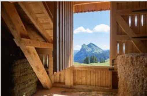
Kräftige Querschnitte und Profile für hohen Schnee- druck und extremes Wetter widersprechen nicht feinen Details wie den Licht- und Luftschlitzen im Berge- raum.
