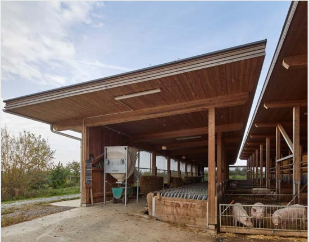
Deutlich zu erkennen: Die beiden flachen, auf Abstand gesetzten Pultdächer, die den offenen, zusammenhängenden Stall abdecken mit (von links) Futtergang, Fressplatz, zum Wetter offenen Mistgang und trockenen Liegeplatz mit Liegenest.
