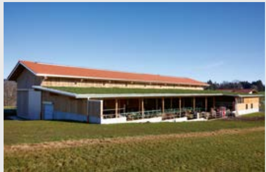
Einpassung ins Gelände. Im Detail: die Südwand des Stalls. Und im Großen: Rot das hohe, steile Dach; grün das flache.
