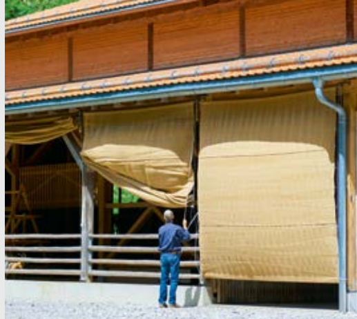
Es muss nicht immer Plastik sein. Grob gestrickte Jute verschafft den Ziegen gleichwertigen Wind- und Schneeschutz.
