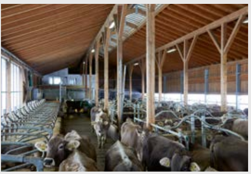
Bewährte und preiswerte Holzbauart: Satteldach, Stützen, tragende Außenwände. Richtig angeordnet, stellen Stützen keine Beeinträchtigung dar.
