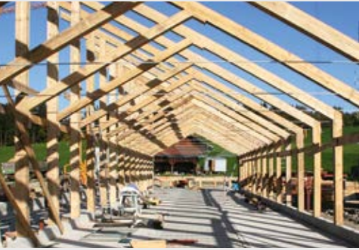
Der Holz-Rohbau: 20 Bünde im Achsmaß 2,40 Meter; Kantholz 20/25 Zentimeter geschraubt, genagelt und mit Knaggen gefügt; Dachschalung zur Aussteifung – bestens geeignet für Selbstbau.
