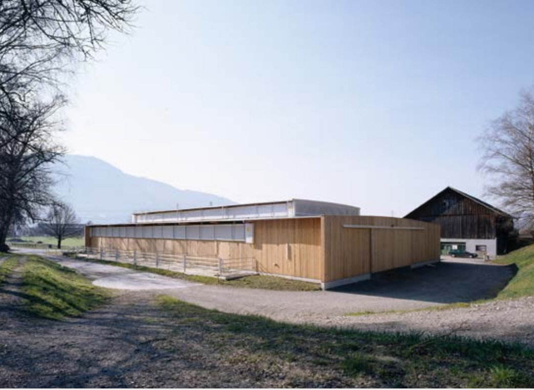
Welches Dach für einen Bau, der so breit wie zwei große Bauernhöfe ist? Belichtung und Belüftung, Baumasse und Konstruktion sowie Landschaftsschutz sprachen für ein gestuftes, flach geneigtes Dach.
