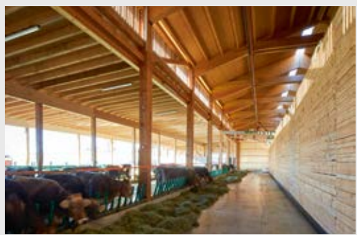
Zwei Bauweisen: Der Stall mit Grasdach auf Balkendecke und enger Sparrenlage. Die Bergehalle mit Leimbindern und Pfettenabsaugung.
