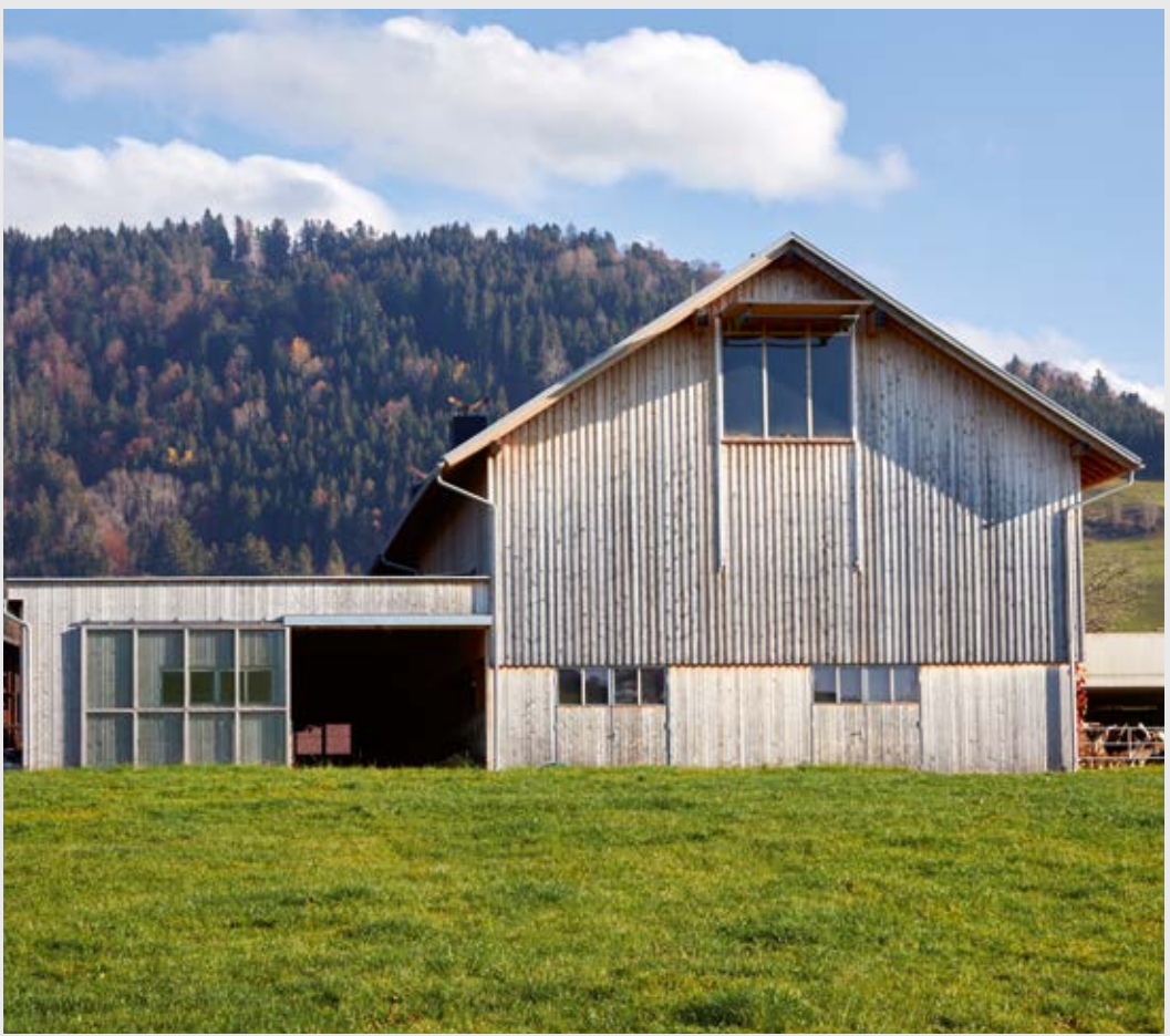
Wetterseite des klassischen Wälderhauses – heute so gut wie seit Jahrhunderten: Holzständerwand mit (oben) Boden-/Deckel- und (unten) Nut-/Feder-Schalung und gleichartigen Toren. Der betonierte Anbau ist holzverschalt.
