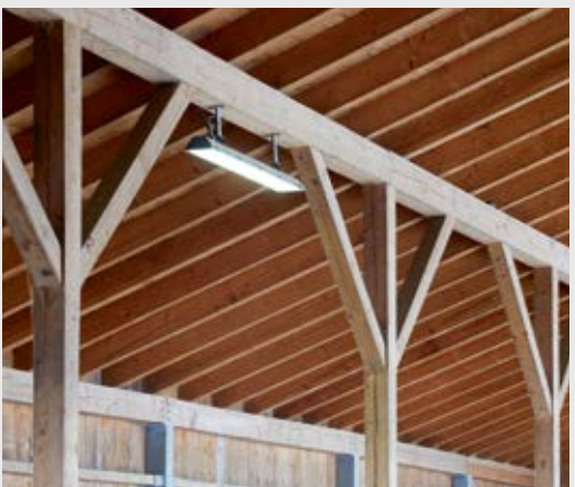
Balken, Pfette, Stütze, Bug: Konstruktive Klarheit ist die Grundlage für eine gute Form.
