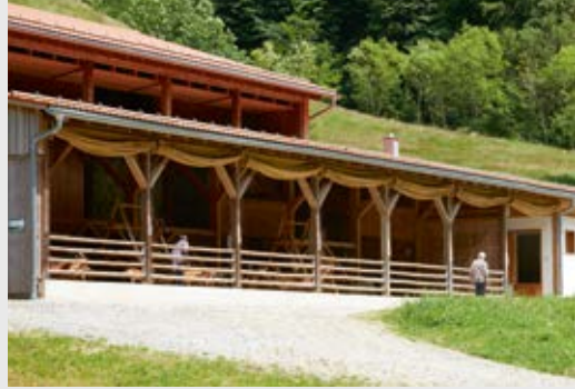
Der Maßstab handwerklicher Holzbaukultur prägt die Form: Vollholz, eng gestellte Stützen, aussteifende Büge, geneigte Dächer mit Ziegeldeckung.
