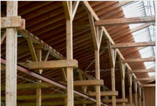
Mit Versatz zimmereremäßig gefügte Bünde in Längsrichtung; Zangen des Ingenieurbaus in Querrichtung – die klare Gliederung ergibt eine einleuchtende Struktur und starke Form.
