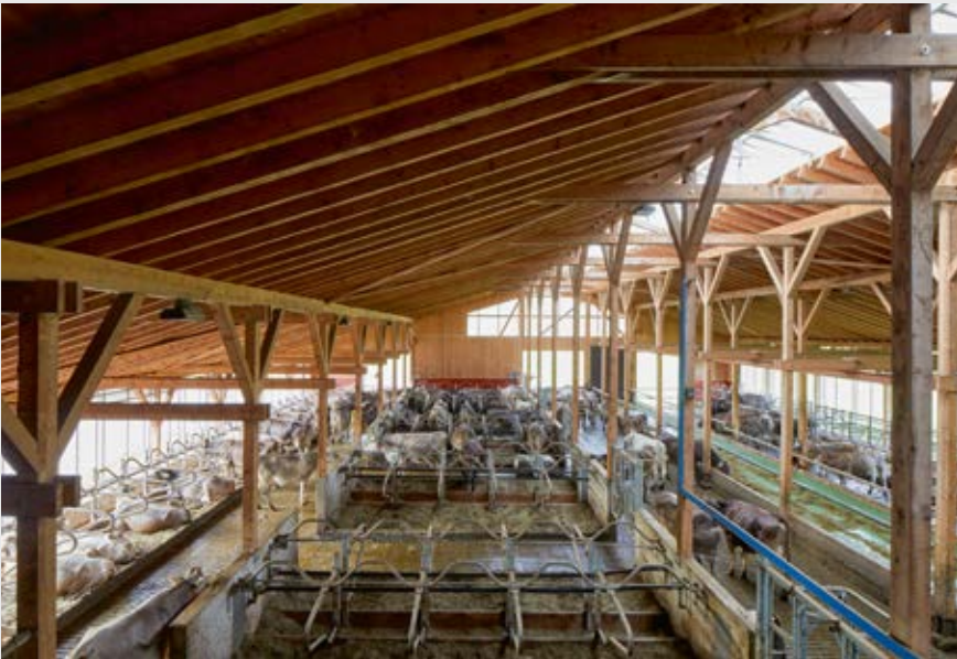
Liegeplätze längs und quer, Fressgang, Futtertisch und Liegeplätze fürs Jungvieh: Die Stallgliederung passt zu den eng gestellten Vollholz-Stützen – für eine weit gespannte Konstruktion gibt's keinen Bedarf.
