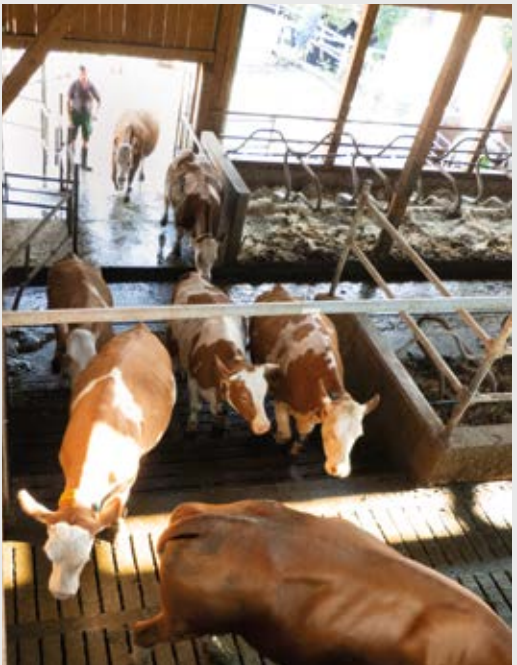
Die unterschiedlichen Niveaus des Laufstalls werden durch Kuhlreppen mit wissenschaftlich ermittelter Steigung und Gummibelag verbunden.
