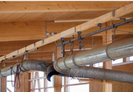
Marke Eigenbau: Der findige Bauer schont seine Kräfte, dreht ein altes Heugebläse um und bläst regelmäßig Streu in den Liegebereich.
