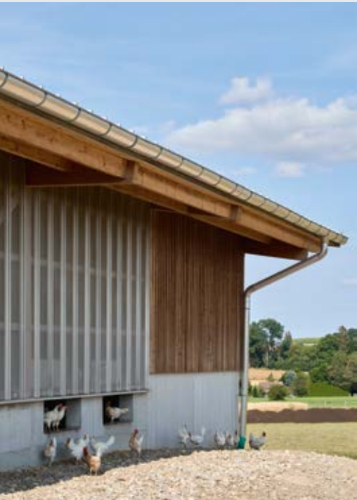
Pragmatisch und jeweils angemessen konstruiert: Die erdberührenden Teile sind betoniert, der Stall ist eine Holzkonstruktion, belichtet und belüftet über Elemente aus gelochtem Blech.
