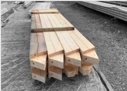
Der Ehrgeiz bestand darin, die Hallenkonstruktion mit klassischen Zimmererverbindungen ohne Stahlknoten zu fügen. Serielle Fertigung macht es erschwinglich.
