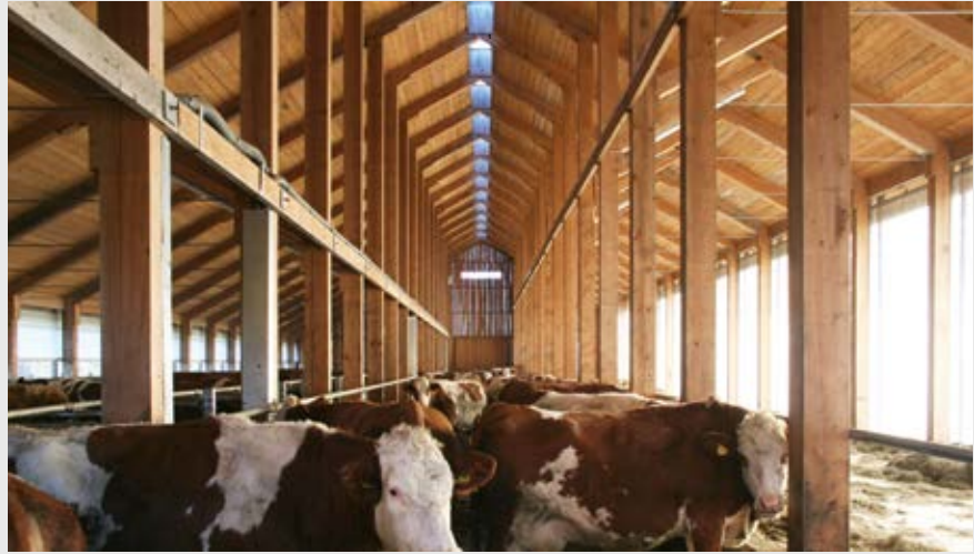
Das Satteldach teilt sich optisch durch die Streben in drei „Dächer“: der Liegebereich, der Fressgang, der Futtertisch. Im Bild das „Mittelschiff“ des Fressgangs.
