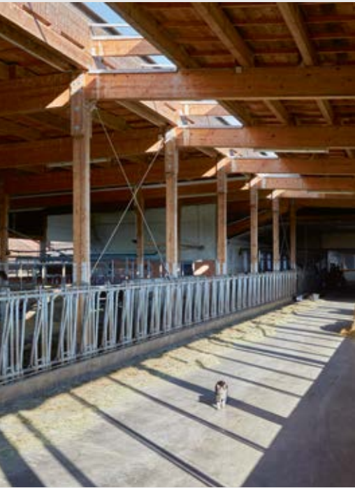
Klassischer Skelettbau: Vollholzstützen, Auskragung mit Rundstahl, Leimbinder nach Statik, einheitliche Balkenlage und Schalung.
