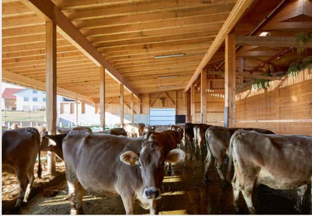
Der Fressgang mit offenem Stall (links) und Bergehalle (rechts). Am Futtertisch stoßen der flache und der hohe Bau aneinander. Der Stall bleibt das ganze Jahr offen.
