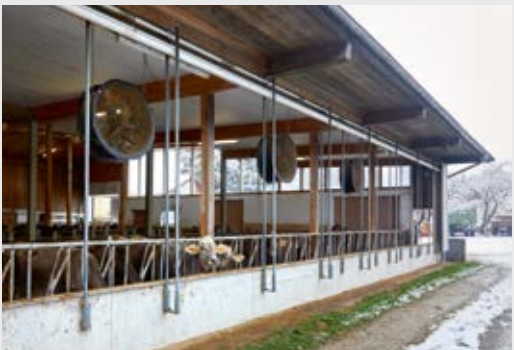
Hier ist endgültig Schluss. Die Südwestfassade ist mit Curtains verschließbar. Eindrucksvoll die freihängenden Ventilatoren, die für sommerliche Frische sorgen.
