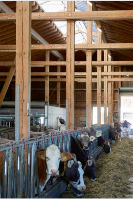
Richtig in Position gebracht sind eng stehende Stützen und Zangen in preiswertem Vollholz keineswegs störend, sondern geben räumlichen Maßstab.
