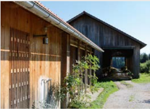
Gebräuchliche Form – Satteldach, knapper Dachüberstand, Bretterschalung – mit Bauschmuck: Das ornamentale Muster (Wand links) dient der Belüftung des Technikraums.
