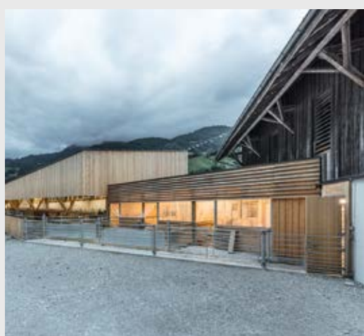
Der Zwischenbau für Kälber vermittelt zwischen Altbau mit Berge- und Melkraum und neuem Stall; der ansteigende Boden lässt sich errahnen, das gegensinnig fallende Dach wird deutlich.
