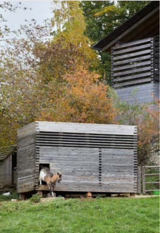
Auch beim Ziegenstall auf dem Grundstück des „gestrickten“ Wohnhauses der Familie Kühnlein jun. das gleiche Schichtungs-Prinzip: In diesem Fall durch Holzbretter mit dem Rechteck-Querschnitt 14/6 Zentimeter.
