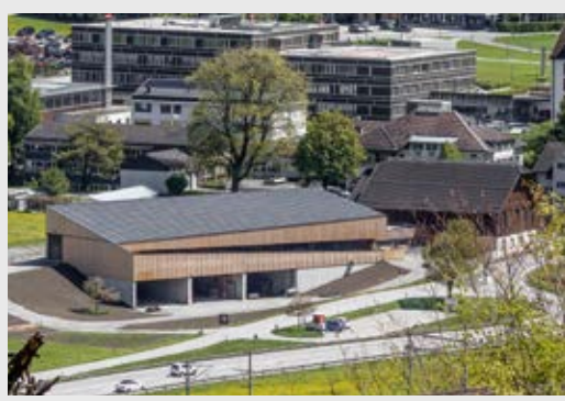
Anspruchsvolle Geometrie: Pultdach mit fallender Traufe, davor gegenläufig fallende Begrenzung des Laufhofs. Unter Stallniveau Stellplätze, Jauchekästen, Mistkeller. Rechts der alte Hof.
