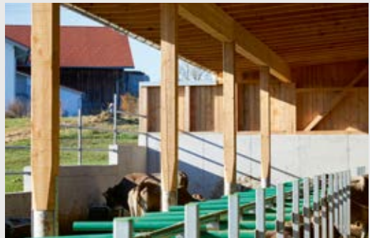
Sorgfältig auch im Detail: Runde Stützenfüße im offenen Stall, kunststoffgeschützter Stallausbau.
