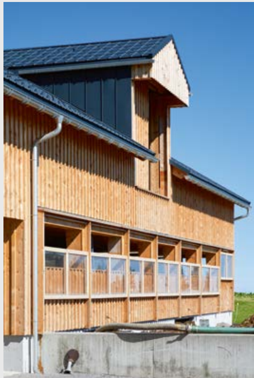
Giebel für einen Kran gegenüber hangseitigem Wiederkehr; die umlaufenden Hebefenster des Stalls; links der Zugang zum Sennhof, rechts daneben der Kasten für mechanische Entmistung.
