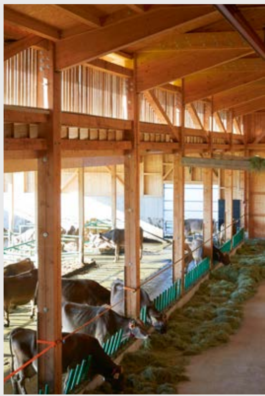
Der Futtertisch liegt an einer Seite der Bergehalle; von hier werden die Heuboxen mit Nachtrocknung befüllt. Der tiefere, offene Stall vermittelt zur Landschaft.
