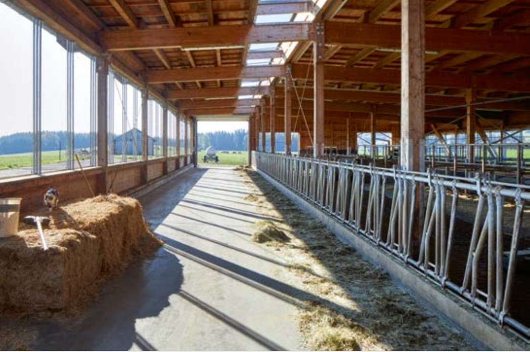
Licht und Luft in Hülle und Fülle: Der Holzbau mit Stütze, Balken und Dachscheibe erlaubt es, die Längswände für flexible Curtains oder Hubfenster eigenständig auszubilden.
