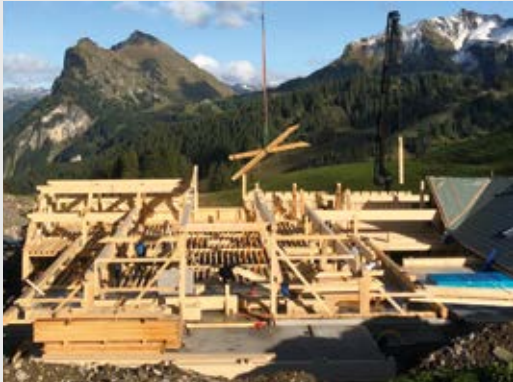
Hebt die Dachbalken hoch, Zimmerleute! Klassisches Handwerk, wenn auch unterstützt durch Kran und Elektromotor. All das unter der Kanisfluh, dem heiligen Berg des Bregenzerwalds.
