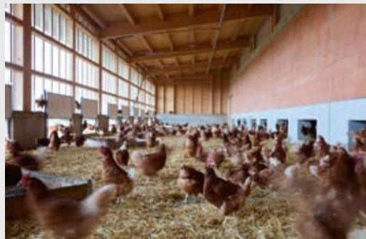
Die Tragkonstruktion ist aus Massivholz, die Dachfläche aus Dreischichtplatten, darauf Holz faserdämmung, eingedeckt mit Stegfalz-Verblechung. Es geht: Stallbau ohne Verbundbaustoffe.
