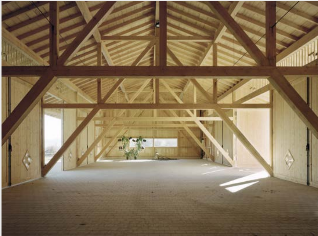
Die Kraftabtragung von Firststütze über Stütze des stehenden Stuhls bis zum Fußpunkt der Fassadenstütze über Diagonalstreben ergibt ein klares, stimmiges Gefüge und erlaubt schlanke Vollholz-Profile.
