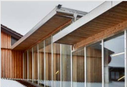
Die Stirnseiten sind festverglast mit handelsüblicher Industrieverglasung; Das massive Holzdach mit reichlich Überstand hat wegen flacher Neigung eine Blechdeckung.
