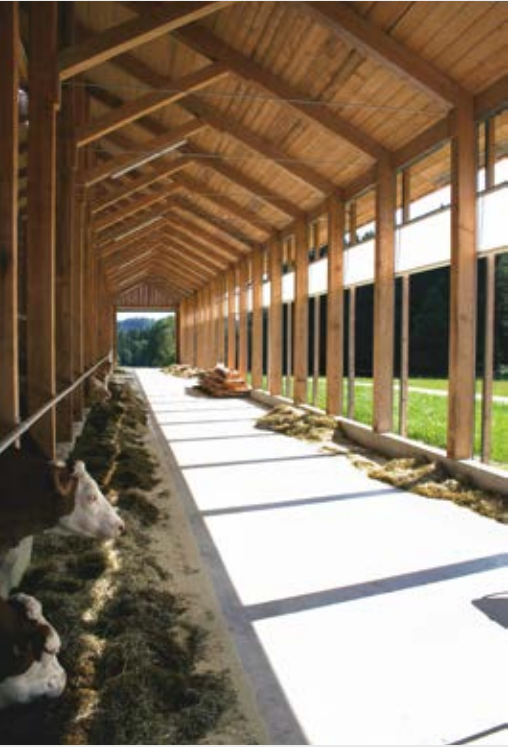
Der Futtertisch im Licht der Nachmittagssonne. Ein Raum mit eigenem „Dachstuhl“ – wie der gegenüber liegende Liegebereich, der tiefer ist, da sich das Dach weiter hinabzieht.
