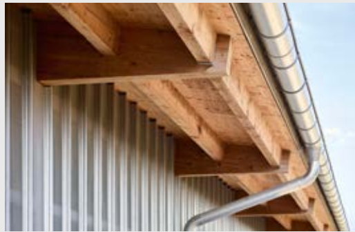
Die Tragkonstruktion ist aus Massivholz, die Dachfläche aus Dreischichtplatten, darauf Holz faserdämmung, eingedeckt mit Stegfalz-Verblechung. Es geht: Stallbau ohne Verbundbaustoffe.
