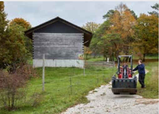
Die geschlossene Westseite des Rinderstalls am Wanderweg auf den Petersberg. Selbst bei der mobilen Zäunung wurde auf die üblichen Kunststoff-Stecklinge verzichtet und ein eigenes Stahlpfosten-System mit variablen Isolatoren entwickelt.
