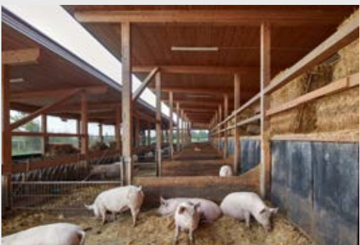
Die Zehnergruppe der Tiere ergibt Raumgrößen der Gehege, deren Achs-Maße fürs Bauen mit Vollholz bestens geeignet sind. Rechts unter dem Strohlager die Liegenester.
