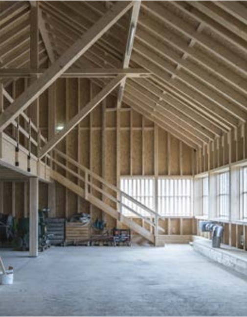
Elf Jahre nach dem Stall wird der alte Hof um ein Lager verlängert. Firststützen, baumartige Streben und Zangen interpretieren den alten Pfettendachstuhl neu. Das einheitliche Gefüge von Dach und Wand prägt den Raum.
