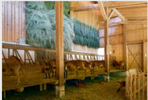
Die über Dachabsaugung belüfteten Heuboxen, davor der aufgeständerte Futtergang, darunter ein Rückzugsbereich der Tiere im Laufstall mit Streu auf Stampflehm.
