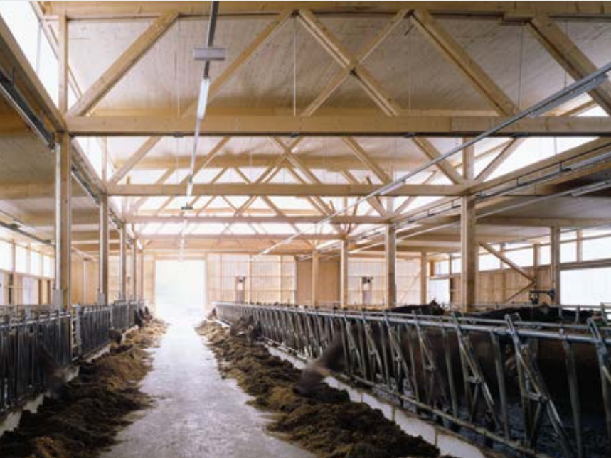
Fachwerkträger aus addierten Vollholzprofilen über- spannen die weite Mitte; die Konstruktionshöhe erlaubt einen zentralen Lichtkranz mit exzentrischem Dach.
