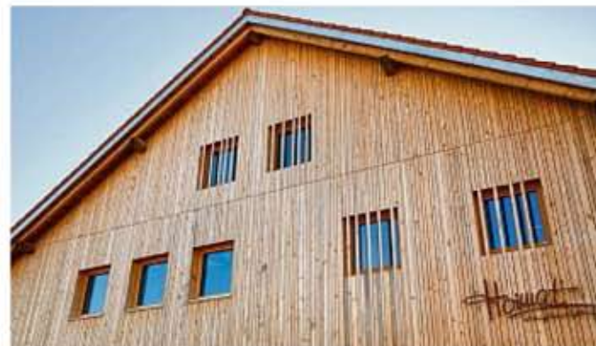
Typischer Holzschirm der alten wie neuen Fassade: heute gedämmt und mit Weißtannenschalung versehen. Auch alle neuen Fenster sind aus diesem heimischen Holz.
