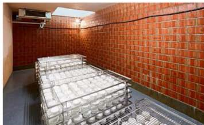
Nichts geht verloren. Heute wie einst der letzte Raum des Materialflusses: die ehemalige „B'schütte“-Grube ist nun Reiferaum des Käses - mit dem Segen von Bau- und Gesundheitsamt.
