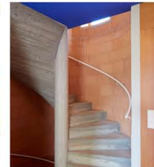
Unverkennbar Leidenschaft des Handwerks. Mit modernem Stein einen Zylinder in Sicht zu mauern, eine gewendelte Betontreppe vor Ort zu schalen, ist ehrgeizig. Da passt kräftige Farbe.
