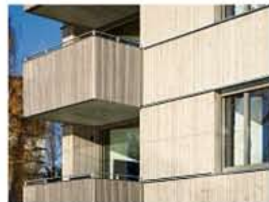
Gleich der Baustoff, unterschiedlich Zuschnitt und Einbau: Senkrechte Lärchenbretter für die Hauswand, stehende Stäbe für die Balkone. Passend: Dezentale Bänder und Geländer aus Metall.
