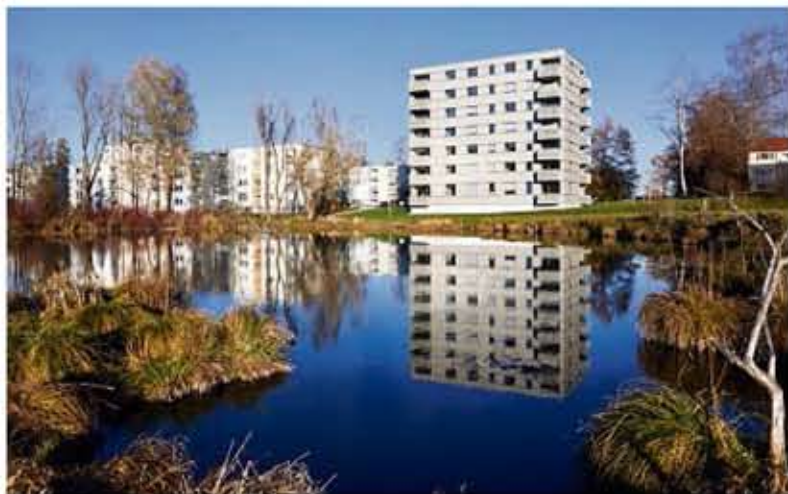
Am Stadtrand von Kempten, vor unverbauter Landschaft unterhalb des Marienberg, erhebt sich eines der höchsten Holzbauten Bayerns. Die Höhe erlaubt Abstand zur Nachbarbebauung und öffnet Blickfenster aus der Siedlung ins Land.
