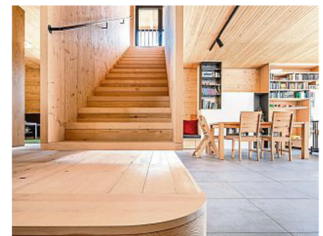
An der Firstpfette aufgehängt: die Decke über EG samt Treppe. Darunter frei durchlaufend: die Sitzstufe.
