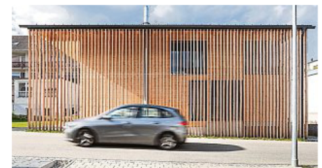
Der Holzschirm an der Straße schützt vor Verkehr und Einblicken und ist Rankhilfe für eine grüne Wand aus Hopfen.
