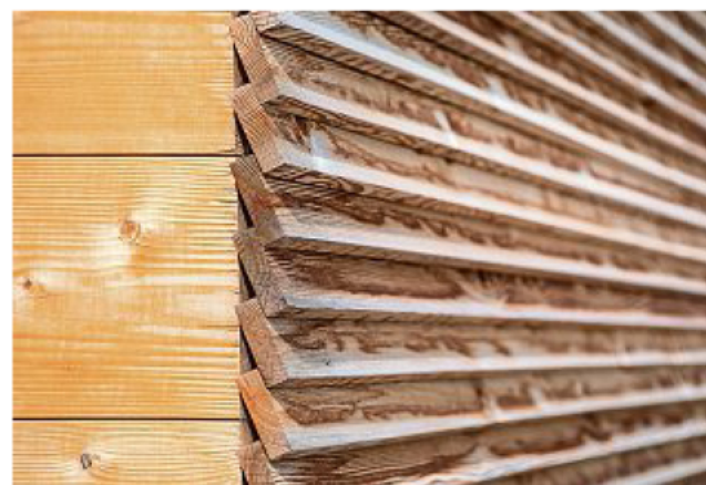
Die letzte Schicht der massiven Holzwand mit gestulpter Schutzschalung nur wo mit Regen zu rechnen ist.
