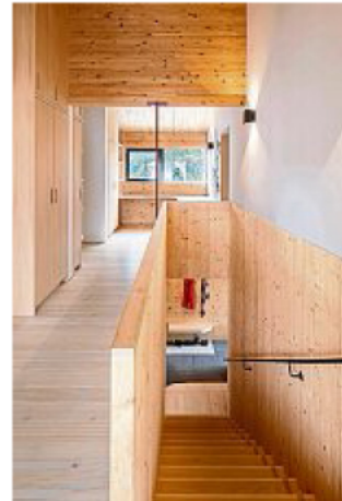
Flur im Schlafgeschoss mit Schrankwand und Arbeitsplatz; mittig die Firstpfette, an der die Decke hängt.
