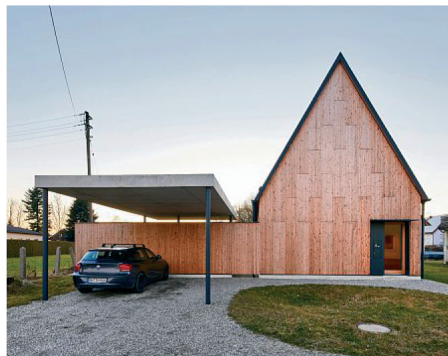
Feierabend. Einfache, gekieste Vorfahrt, gedeckter Stellplatz, eine Holzwand, die zum steilen Giebel wird mit dem Eingang als einziger Öffnung – coming home in Heimertingen.
