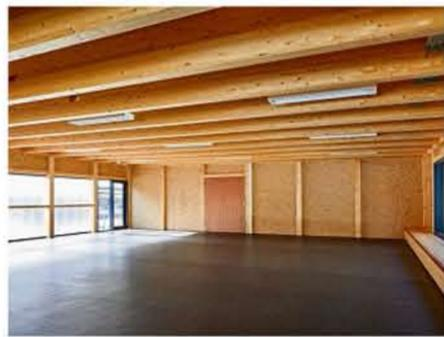
Die Trainingskalthalle zeigt eine kostengünstige Möglichkeit einfacherer Ingenieurholzkonstruktion für stützenfreie Hallen.
