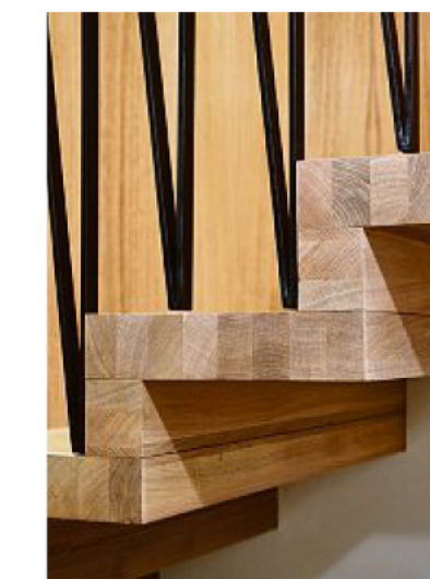
Allgäuer Handwerkskunst: Sowohl die Faltung der Eichenstufen als auch das geschmiedete Band der Geländerbrüstung.
