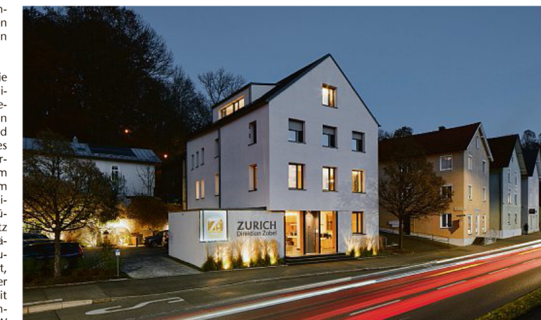
Am Puls der Zeit und doch dank massiver Wände, Schallschutzfenstern und einem Vorbau mit intimer Hof dem lauten Treiben der Stadt ein gutes Stück entrückt.
