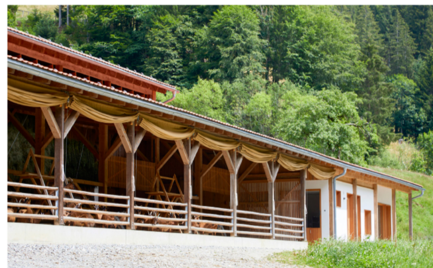
Neuartig die Form und doch ein charakteristisches Allgäuer Bauernhaus: Zur Morgensonne der weiß verputzte Steinbau, nach Westen die leichte Holzkonstruktion für Tier und Heu, weit geöffnet nach Süden und geschlossen zur Wetterseite.
