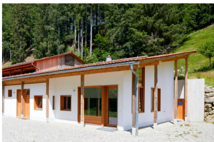
Der Holzbau gibt den Rhythmus vor, der Steinbau erlaubt freie Fassadengestaltung. An der südöstlichen Gebäudeecke liegt der Hofladen mit genügend Vordach für wettergeschütztes Verweilen.
