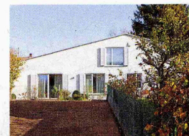
Der Blick durch angrenzende Gärten zeigt ein fast vertrautes Bild von Haus mit Tür und Fenster.
