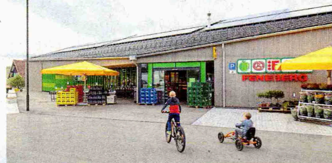
Am Gebäudeknick: Eingang geht zum Parkplatz, Schaufenster zur Ortsmitte.
