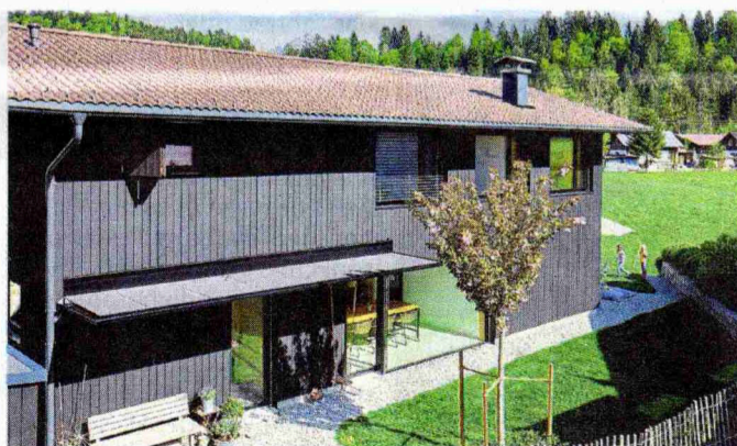
Einfirsthaus, Proportion 1:2. Hinten Gast und Bad, an Stelle der Tenne der Essplatz, am Kopf Wohnen.
