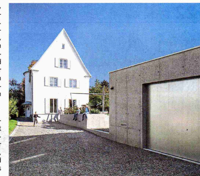
Ein Kiesweg führt zu Garage und Haus; dazwischen liegt leicht erhoben der geschützte Freisitz.
