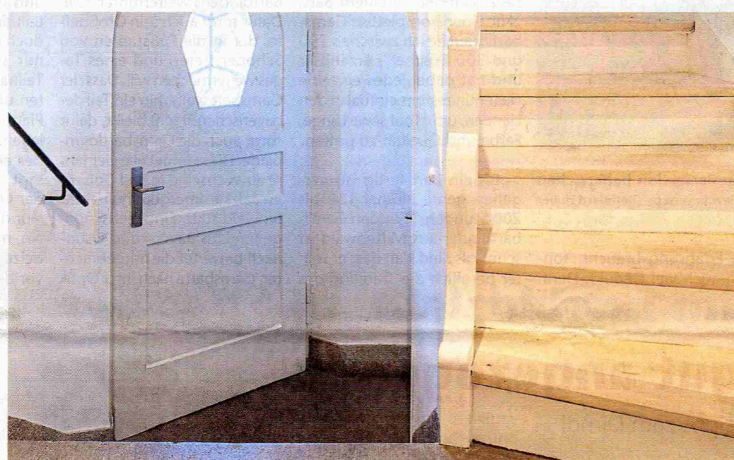
Blickfang und räumlicher Dreh- und Angelpunkt: Das Türmchen des Treppenhauses empfängt den Gast, weitet sich zum Entree, verbindet dynamisch die Stockwerke.
