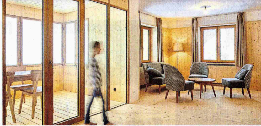
Wohnzimmer mit eingreifender „Altane“. Ausgewogen: Boden und Wandverkleidung in Fichte; Decke und Fries gekalkt; gliedernde Eichensprossen.
