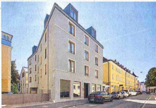
Ein Neubau auf den zweiten Blick: unaufgeregt und edel
