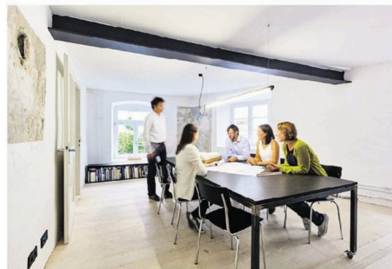
Der großzügige Raum für Besprechung und Vortrag. Ein Stahlträger ersetzt die vormalige Trennwand.
