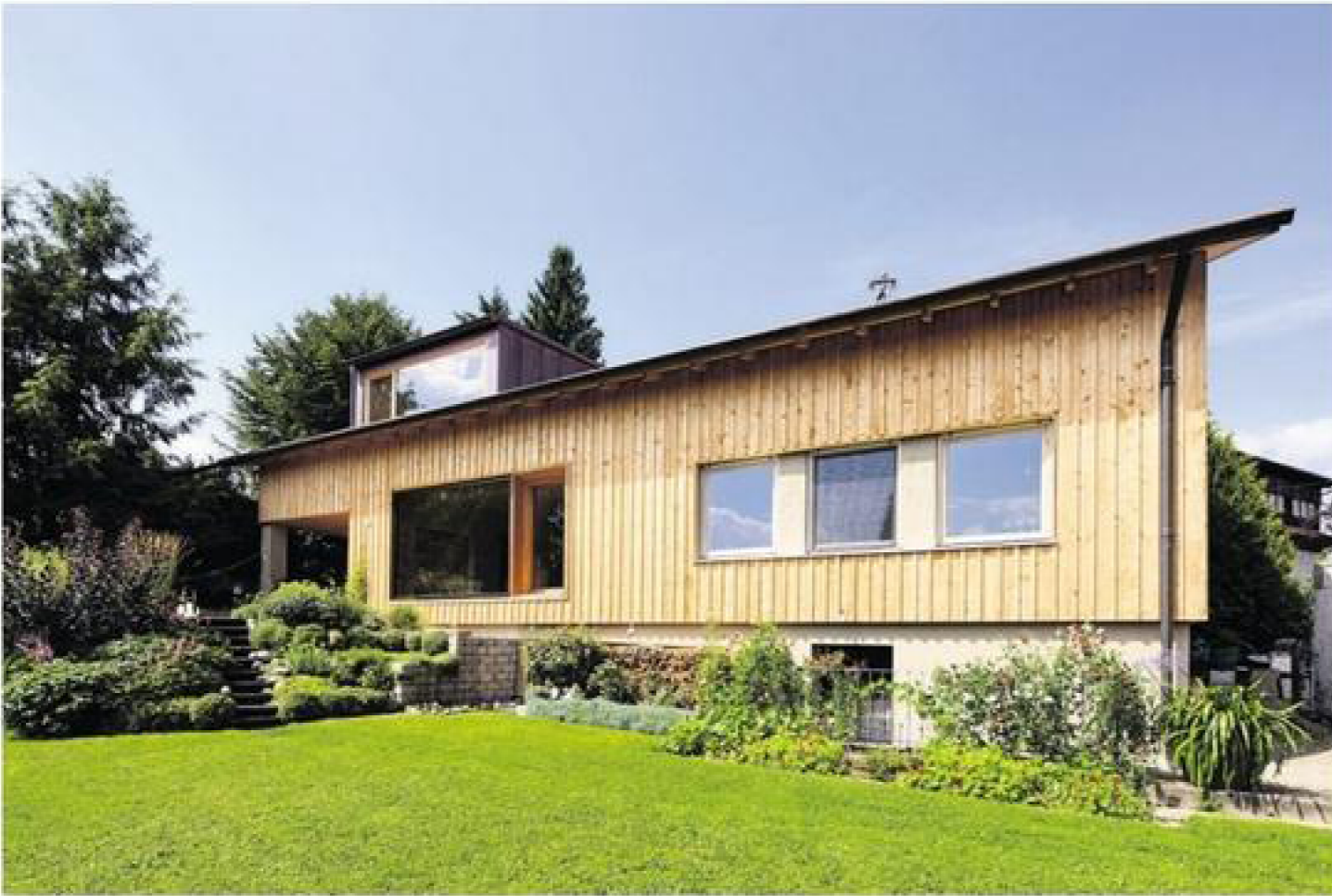
Das ehemalige Schulhaus vom talseitigen Garten. Keller und Sockel sind geblieben; das Erdgeschoss erhielt eine neue Hülle aus Holzfaserdämmung und Rauschalung, die alte Wand aus Hochlochziegeln überzeugt durch ihre Speichermasse; je drei Klassenzimmerfenster sind zusammengefasst, im Wohnraum zum großen Panoramafenster.
