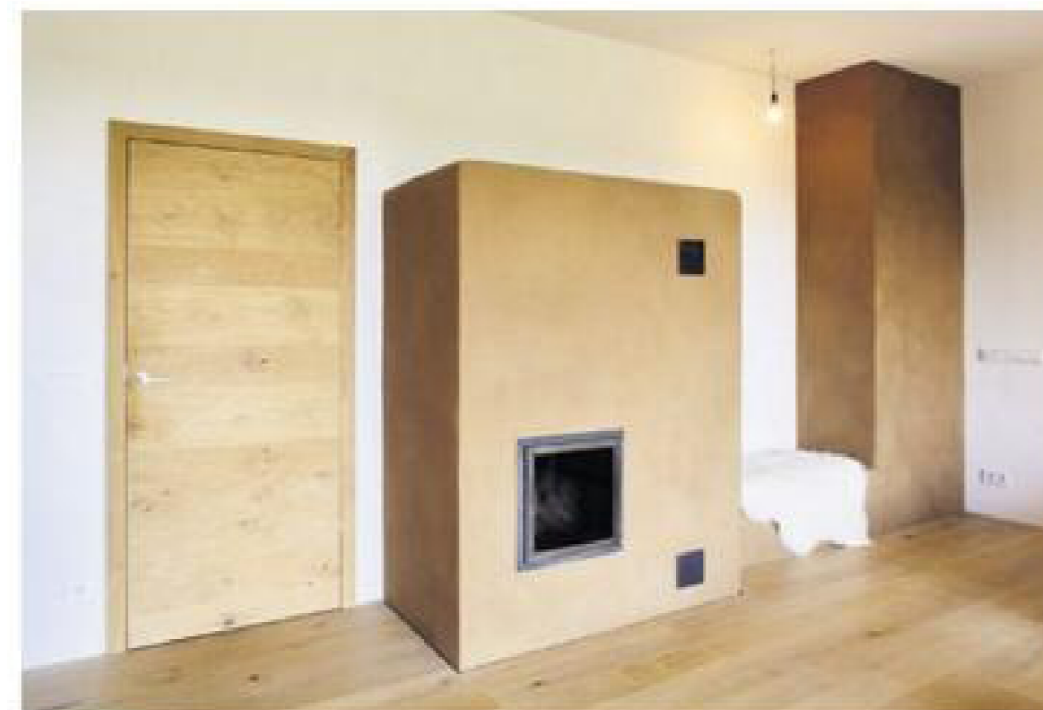
Ein großzügiger Grund-Ofen in Lehmbauweise reicht für die meisten Tage des Jahres.
