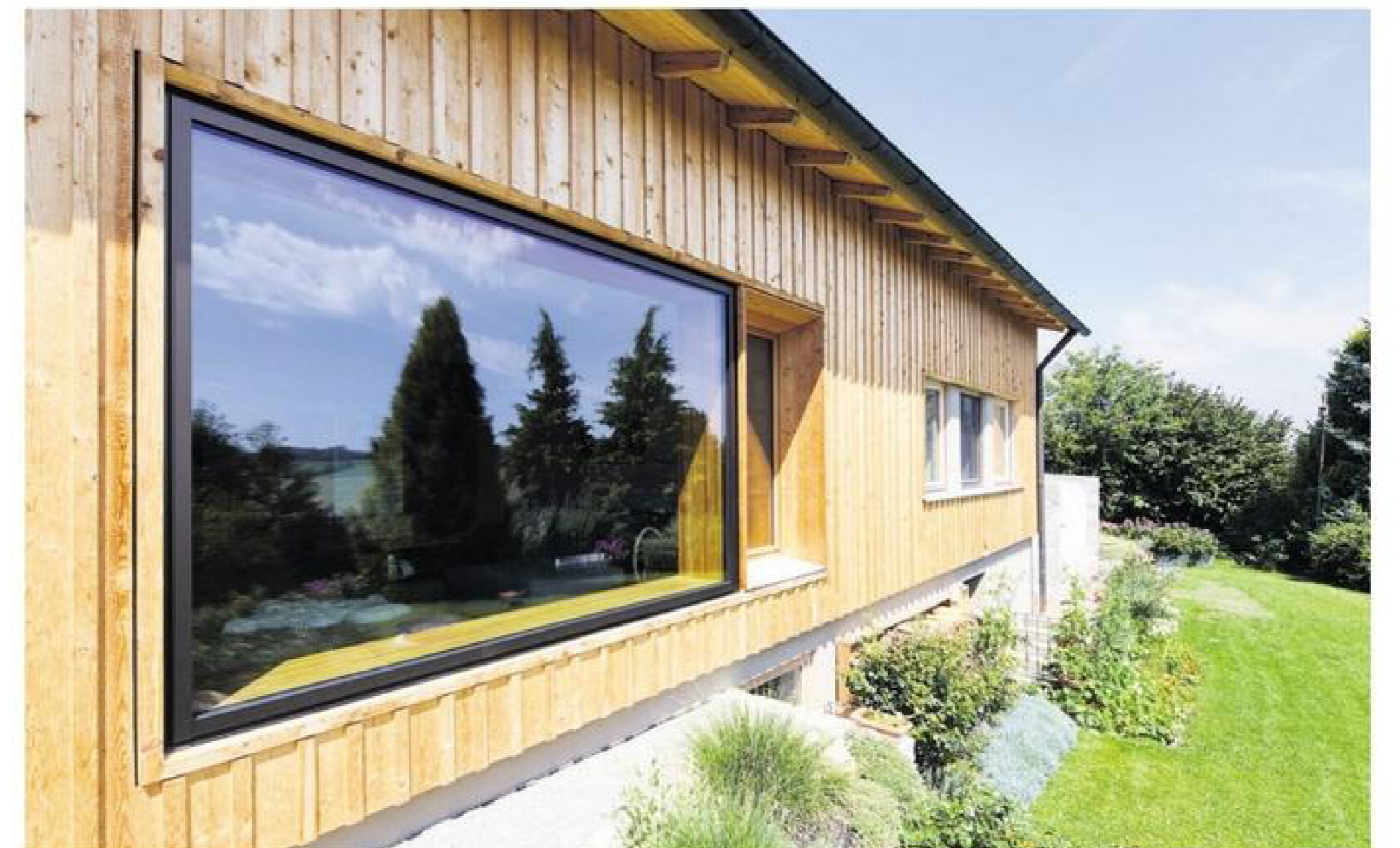
Ungezwungenes Beieinander traditioneller und moderner Technik bei der einfachen Stahlschalung und der aufwändigen Verglasung.
