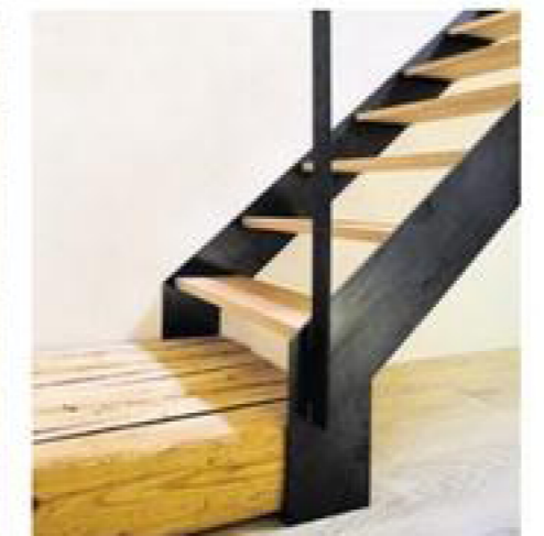
Details: das Badfenster mit angezogener Fensterlaibung; Treppe: Stahl, Eiche und alte Eisenbahnschwellen.
